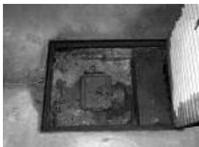
Widok wypełnionej mulem studzienki odprowadzającej wodę z powierzchni posadzki garażu podziemnego
