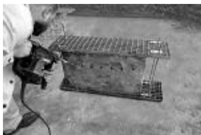
Fot. 1. Wykonanie otworów w murze testowym do wprowadzenia iniektu
