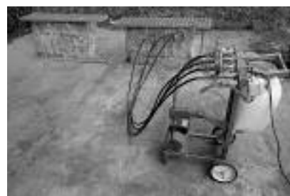
Fot. 2. Wykonanie bariery przeciwwilgociowej na drodze iniekcji niskociśnieniowej Photo 2. Creating waterproof barrier by low pressure injection [Fot. Autorzy]
