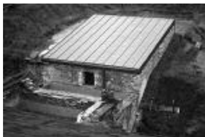
Fot. 3. Widok wykonanego w 2012 r. zadaszania nad celą i izolacji sklepień nad wartownią [Fot. S. Majchrzak] Photo 3. View made in 2012 the roof above the cell and the insulation of the vaults above the guardhouse [Photo S. Majchrzak]
