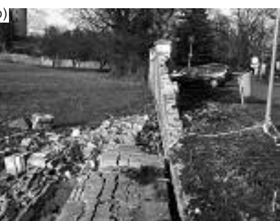
Fot. 3. Widok muru: a) odchylonego od pionu (sytuacja bezpośrednio przed katastrofą); b) ten sam fragment muru po zawaleniu się
