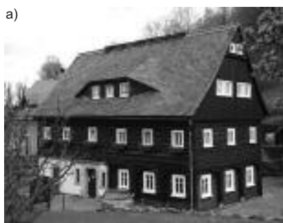
Fot. 1. Dom przysłupowy we wsi Waltersdorf w Czechach (a) z ścianą wieńcową na piętrze podpartą słupami (b) (czes. Podstavkový Dum): [Fot. E. Trocka-Leszczyńska] Photo 1. Upper Lusatian house in Czech Republic (a) with timber walls on the first floor supported by wooden pillar (b) (Czech.: Podstavkový Dum) – in the village of Waltersdorf
