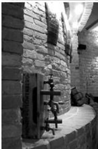
Fot. 8. Przykłady efektów renowacji murów piwnicznych
