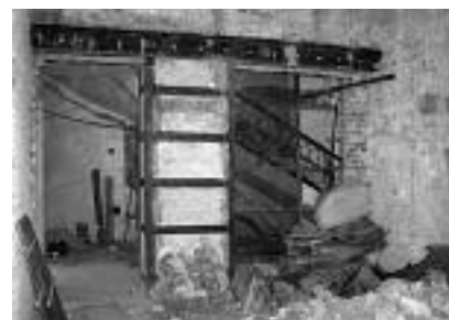
Fot. 6. Tworzenie otworów w poziomie parteru
