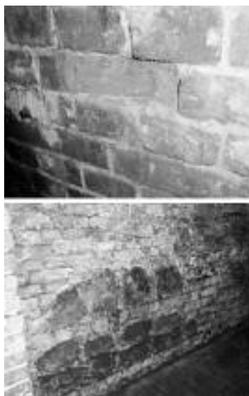
Fot. 4. Stan techniczny murów w piwnicy
