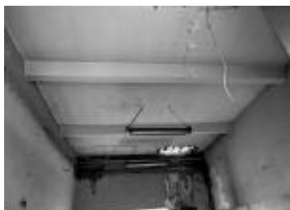
Fot. 1. Strop ceramiczny na belkach stalowych nad parterem Photo 1. Ceramic floor on steel beams over ground floor
