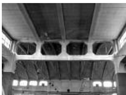
Fot. 3. Żelbetowa kratownica Vierendeela wraz z opartymi na niej dźwigarami łukowymi dachu części wyższej hali oraz ryglami żelbetowymi stropodachu części niższej hali [Fot. A. Klimek] Photo 3. Ferroconcrete Vierendeel truss with arch girders of the higher part of the hall and ferroconcrete bolts of the lower parts leaning on it [Photo A. Klimek]
