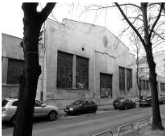
Fot. 1. Elewacja frontowa hali z wypiętrzoną częścią centralną oraz niższymi skrzydłami bocznymi [Fot. A. Klimek] Photo 1. The hall front facade with higher central part and lower side wings [Photo A. Klimek]
