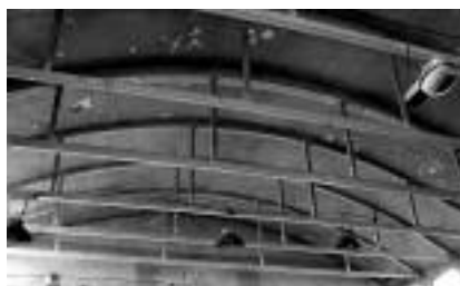
Fot. 2. Łukowe przekrycie żelbetowe części wyższej hali [Fot. A. Klimek] Photo 2. Ferroconcrete arch roof of the higher part of the hall [Photo A. Klimek]
