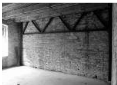
Fot. 4. Kratownica wzmacniająca belkę stalową, podtrzymującą nadwieszoną ścianę szczytową; słupki stalowe sprowadzono aż do posadzki w piwnicy oraz ustabilizowano nadbetonem wykonanym na blachach trapezowych stropu Photo 4. Truss strengthening the steel beam, supporting overhanging party wall; steel columns reach basement floor and are stabilized with concrete layer of composite floors on corrugated sheets
