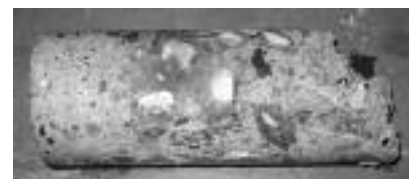
Fot. 3. Odwiert B2 (głębokość karbonatyzacji – 70 mm)
