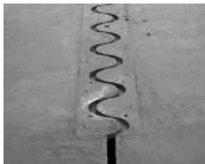
Fot. 5. Pozioma dylatacja sinusoidalna
