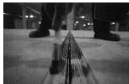
Fot. 7. Wybrudowana dylatacja przygotowana do ułożenia żywicy epoksydowej
