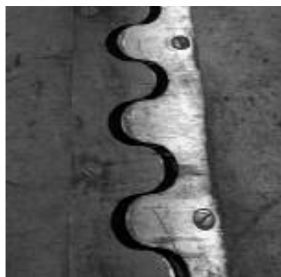
Fot. 6. Uniesione i przeszlifowane brzegi poziomej dylatacji sinusoidalnej
