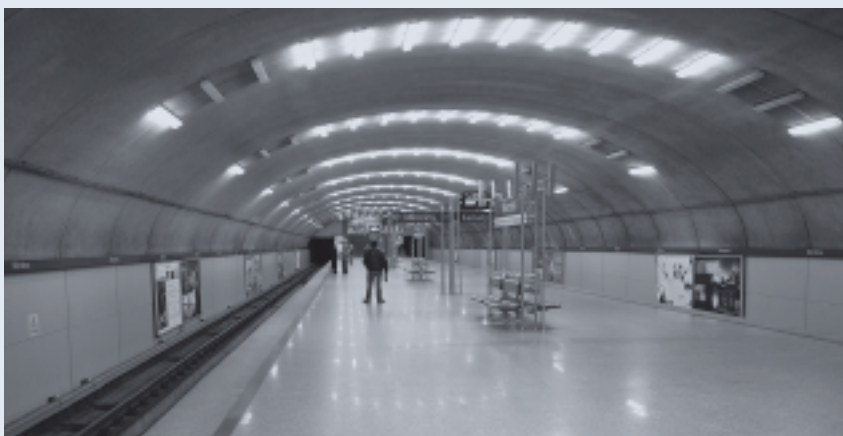
Widok przykładowego pomieszczenia długiego o eliptycznym kształcie przekroju poprzecznego
