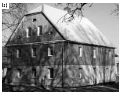
Fot. 3. Budynek w Roszycach przed (a) i po modernizacji (b) [Fot. J. Szlegier] Photo 3. Renovation in Roszyce: before (a) and after (b)
