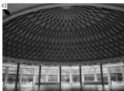
Fot. 1. Centrum ekspozycyjne w Turynie – „Hala B” („Hala Agnelli”) – stan aktualny (2015): a) wnętrze – efekt światłocienia; b) detal podpory bocznej; c) absyda zamykająca Photo 1. Exhibition Centre in Torino – “Hall B” („Agnelli Hall”) – current condition (2015): a) interior – the shadow-light effect; b) a lateral structure detail; c) closing apse
