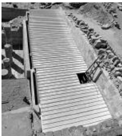
Fot. 3. Dach zabezpieczający Westybuli Kaplicy Hathor [Fot. M. Jawornicki]
