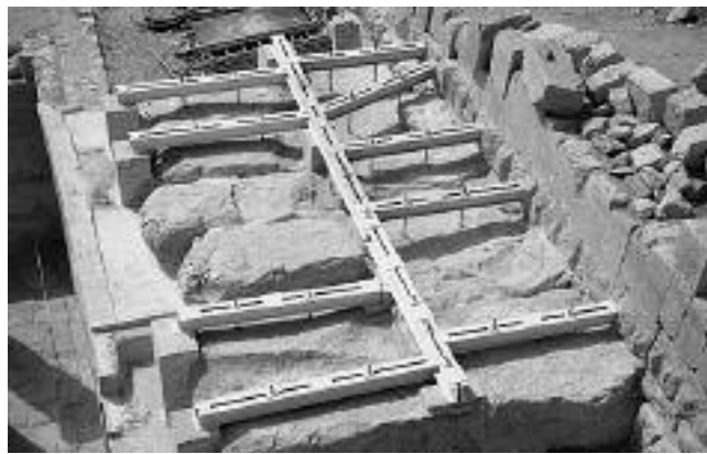
Fot. 2. Konstrukcja stalowa wzmocniająca strop kamienny Westybulu [Fot. M. Jawornicki] Photo 2. Steel construction strengthening the Vestibule stone ceiling [Photo M. Jawornicki]
