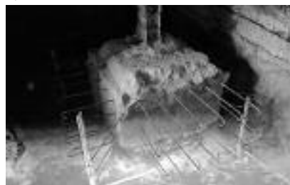
Rys. 2. Wzmocnienie stóp fundamentowych (stworzenie oczepu palowego): a) do-zbrojenie i nadbetonowanie istniejącej stopy; b) zbrojenie scalające istniejącą stopę z nowo wykonywaną
