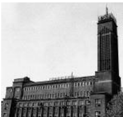
Fot. 1. Widok zniszczonych murów Kościoła Zmartwychwstania w Kownie
