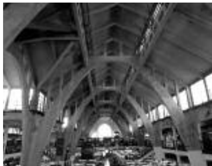
Fot. 1. Widok aktualny żelbetowej konstrukcji hali Photo 1. Current view of RC market hall structure
