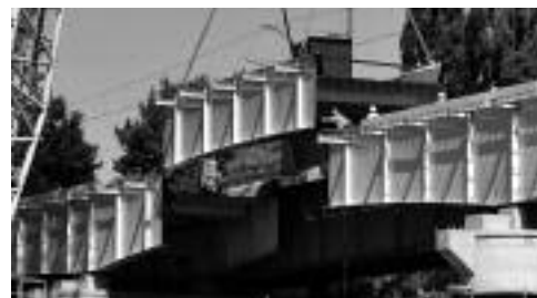
Most kolejowy przez Wartę, Poznań
