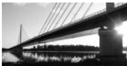
Fot. 2. Widok przęsła głównego mostu Solidarności w Plocku
