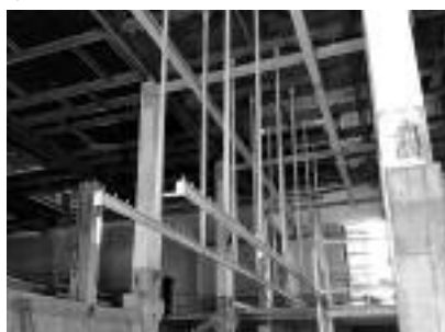
Fot. 3. Montaż podwieszanej części stropu na poziomie +4,00 m do istniejącego stropu stalowego na poziomie +10,00 m
