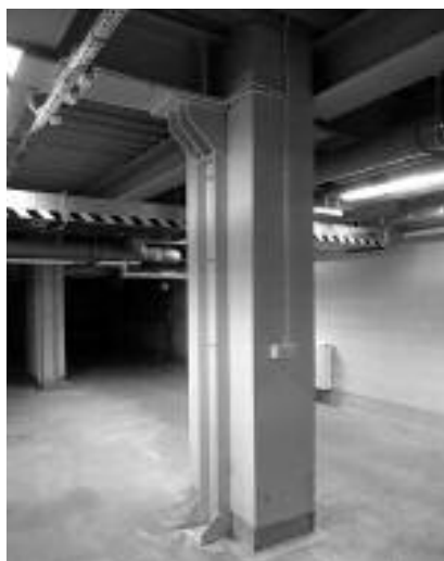
Fot. 2. Sposób połączenia mocno obciążonego stropu na poziomie 0,00 m z istniejącymi słupami żelbetowymi oraz płytą fundamentową
