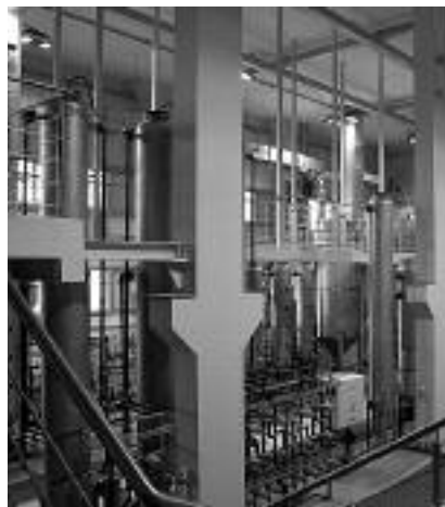
Fot. 4. Wnętrze budynku stacji badawczej po przebudowie: widoczne stropy na poziomach 0,00 m, +4,00 m oraz sufit stropu na poziomie +10,00 m
