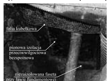
Fot. 5. Widok odkopanej ściany zewnętrznej budynku bez zaizolowanej betonowej fasety przy ławie fundamentowej
