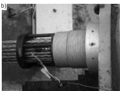
Fot. 2. Urządzenie pomiarowe: a) czujnik przyspieszeń zainstalowany na osłonie cięgna (Hottinger Baldwin Messtechnik GmbH, B12/200); b) czujnik siły zainstalowany na splocie referencyjnym (Freyssinet) Photo 2. Measurement devices: a) accelerometer installed on external protecting HDPE tube (Hottinger Baldwin Messtechnik GmbH, B12/200); b) load cell installed on the reference strand (Freyssinet)
