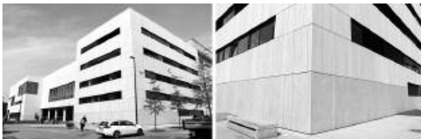
Fot. 1. Przykład elewacji z płyt włóknisto-cementowych nowych budynków w kampusie Politechniki Wrocławskiej
