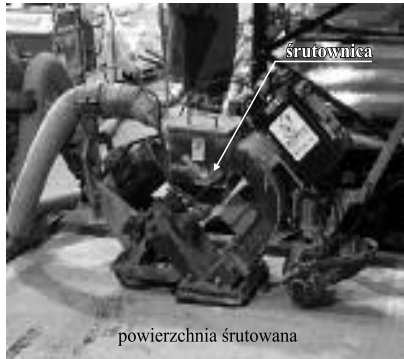
Aparatura użyta do śrutowania powierzchni Device used for shot-blasting the surface
