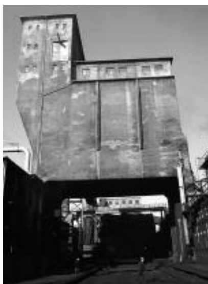
Fot. 1. Widok wieży węglowej Photo 1. View of coal tower
