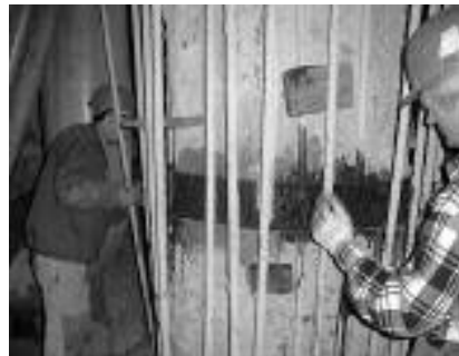
Fot. 3. Wzmacnianie jednego ze słupów Photo 3. Strengthening of one of columns
