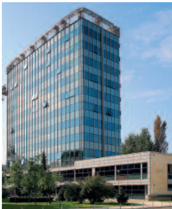
Fot. 4. Siedziba władz Wydziału – wygląd po termomodernizacji
