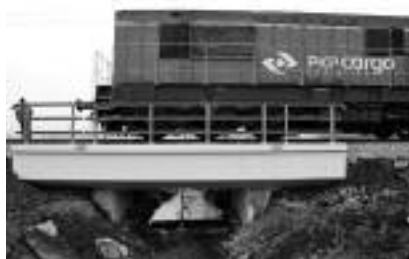
Fot. 2. Ustawienie lokomotywy w trakcie próbnego obciążenia statycznego przęsła
