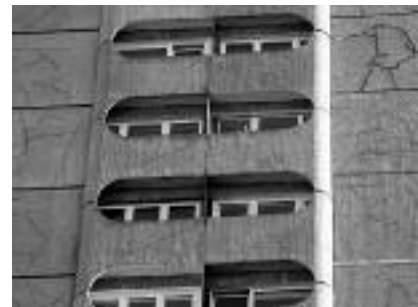
Fot. 4. Balustrady balkonowe i płyty osłonowe ściany szczytowej
