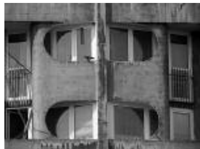
Fot. 3. Oslony balkonowe i słupek ściany frontowej
