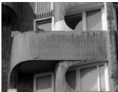
Fot. 2. Balustrada balkonowa ściany frontowej Photo 2. Balustrade at front façade
