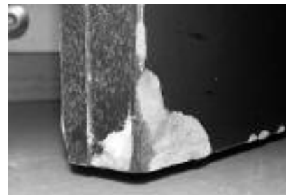
Fot. 2. Drzwi drewnopochodne narażone na działanie wilgoci i wody używanej przy myciu podłóg
