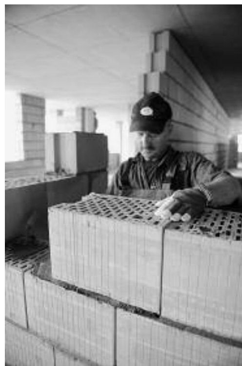
Przegroda międzymieszkaniowa z pustaków Porotherm 25/37.5 AKU
