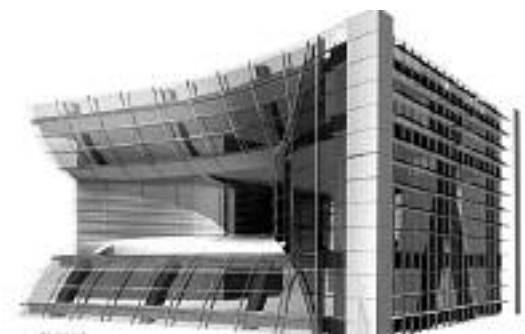
Fot. 3. Portal sprowadzający strumień wiatru w kierunku turbin [1]
