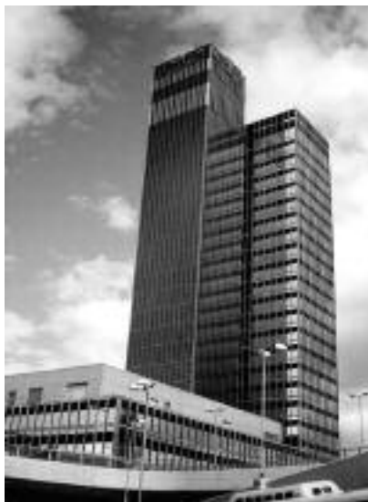
Fot. 1. CIS Tower po renowacji z 2006 r. [Fot. Adrian Welch]
