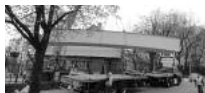
Fot. 2. Transport przęsła mostu FOBRIDGE Photo 2. FOBRIDGE bridge span transport
