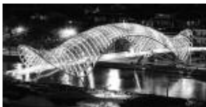
Fot. 1. Most Pokoju w Tbilisi (Gruzja) z zadaszeniem ze szkła i stali [7]
