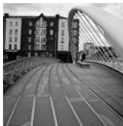
Fot. 4. Most w Dublinie wg projektu Calatravy [7]
