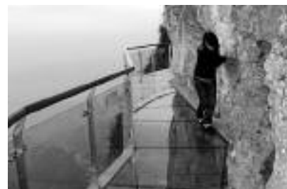
Fot. 6. Kładka w górach Tianmen w Zhangjiajie [7]
