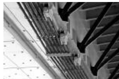
Fot. 2. Sprężenie dolne w przęśle nurtowym
