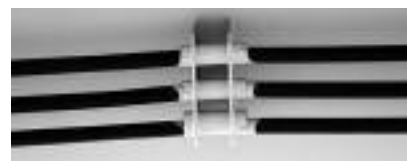
Fot. 6. Dewiator sprężenia dolnego
