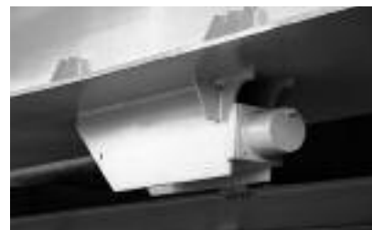
Fot. 5. Zakotwienie sprężenia dolnego
