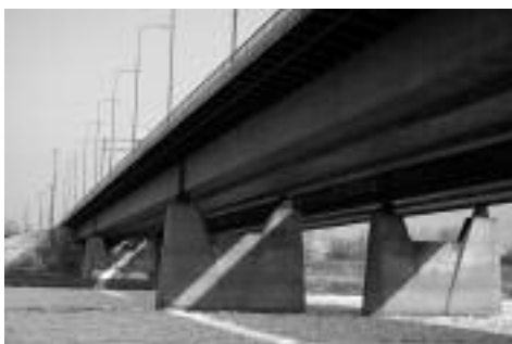
Fot. 1. Widok konstrukcji przed przebudową
