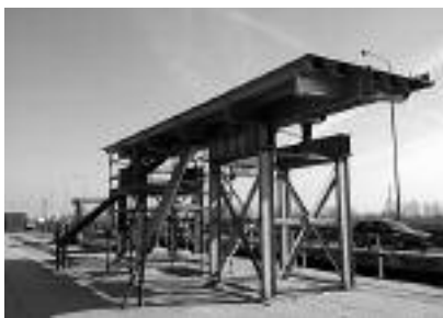
Fot. 4. Segment przygotowany do montażu
