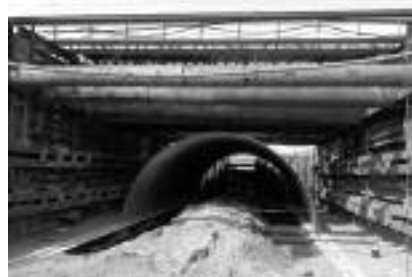
Fot. 1. Obiekt naprawiany metodą reliningu
