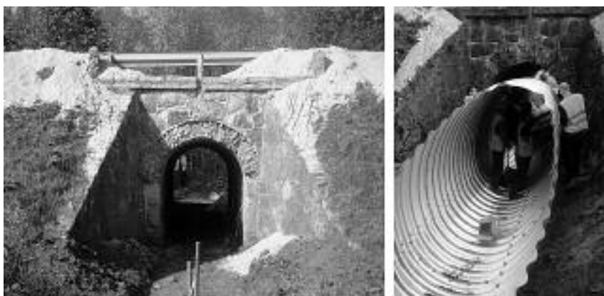
Fot. 3. Konstrukcja kamiennie-ceglana wzmocniona z użyciem konstrukcji wielopłaszczyznowych
