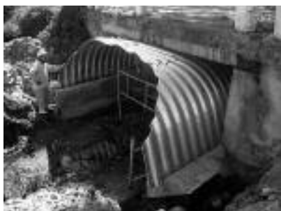
Fot. 2. Konstrukcja wielopłaszczyznowa w kształcie ramownicowym
