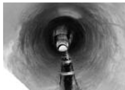
Fot. 3. Przepust z korytem Photo 3. Culvert with a trough
