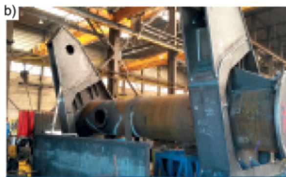
Rys. 4. Widok mostu od strony wału i wsporników podporowych – model Tekla Structures (a) oraz próbny montaż (b) [źródło: RCK Biuro Inżynierskie Sp. z o.o., CSM SteelStructures NV]
