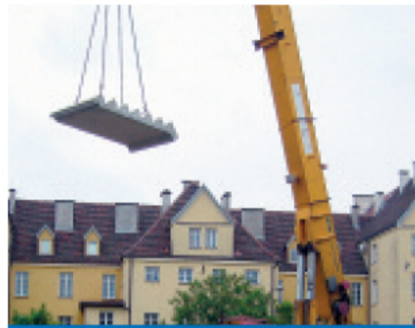
Montaż schodów prefabrykowanych
