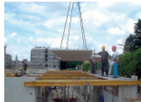
Montaż płyt stropowych LEIER PANEL
