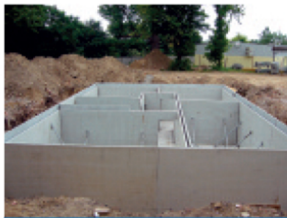
Ściany piwnic wykonane w technologii ścian zespolonych
