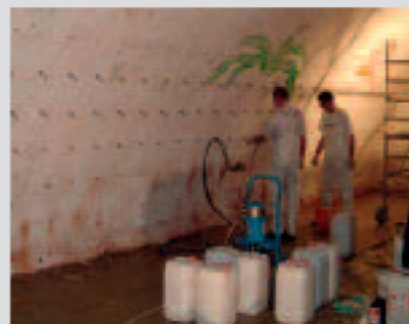
Wykonywanie uszczelnienia kurtynowego
