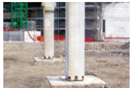
Fot. 1. Połączenie słup – fundament – detal A z rysunku 5
