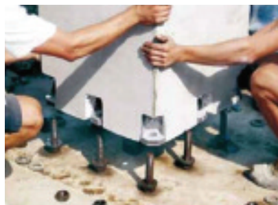
Fot. 1. Połączenie słup – fundament – detal A z rysunku 5
