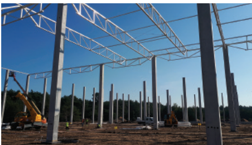
Fot. 3. Budowa NEUCA w Toruniu; montaż elementów konstrukcyjnych
