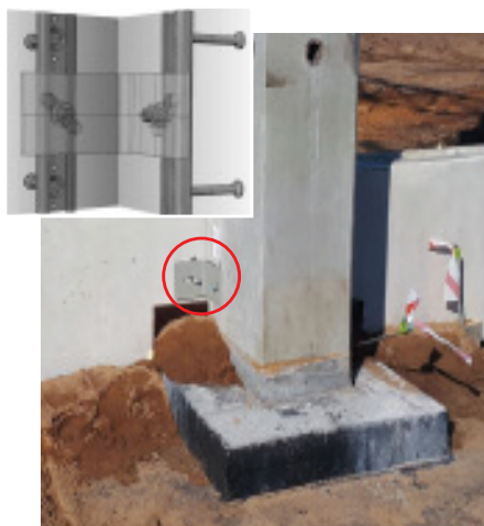
Fot. 2. Połączenie elementów prefabrykowanych typu podwalina – słup [Źródło: http://www.wj-p.pl/files/8014/0127/3033/32pl.pdf ]
