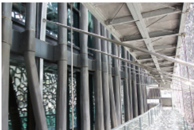
Fot. 5. Połączenie kolumn słupowych w wieńcu stropowym z kolejną kondygnacją
