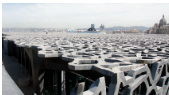
Fot. 3. Panele prefabrykowane nakrywające tarasy MuCEM
