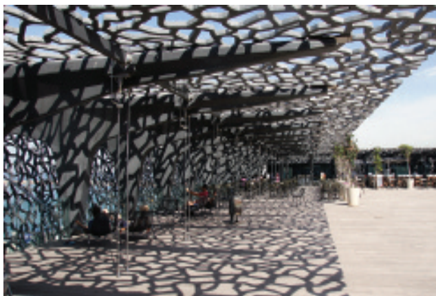
Fot. 6. Teowe dźwigary wspornikowe wraz z zadaszeniem panelami betonowymi
