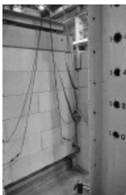
Fot. 3. Obraz zniszczenia modelu referencyjnego M-B Photo 3. Cracking pattern in the reference model M-B
