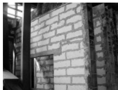
Beton komórkowy wykorzystany w Zakładzie Badań Ogniowych ITB do budowy stanowisk badawczych
