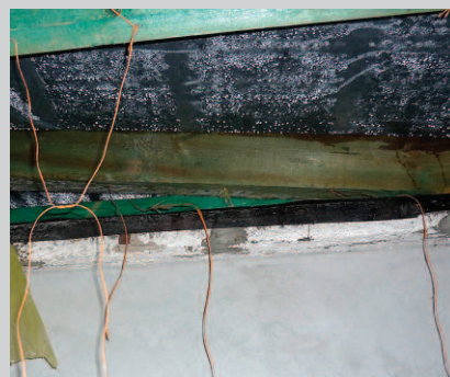
Fot. 2. Po usunięciu paroizolacji i wełny mineralnej w dachu pojawiła się obfita skroplina na MWK. Właściciel zgłosił reklamację na membranę, nie kontrolując wentylacji pod blachodachówką, której nie było z powodu uszczelkek, takich jak na fotografiach 3 i 4
