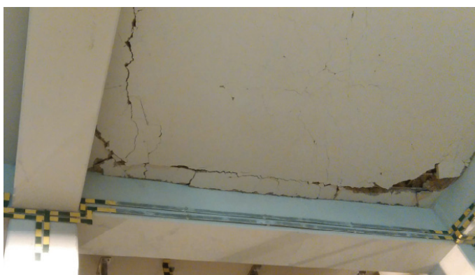
Photo 1. Girder in the support zone Fot. 1. Podciąg w strefie podparcia
