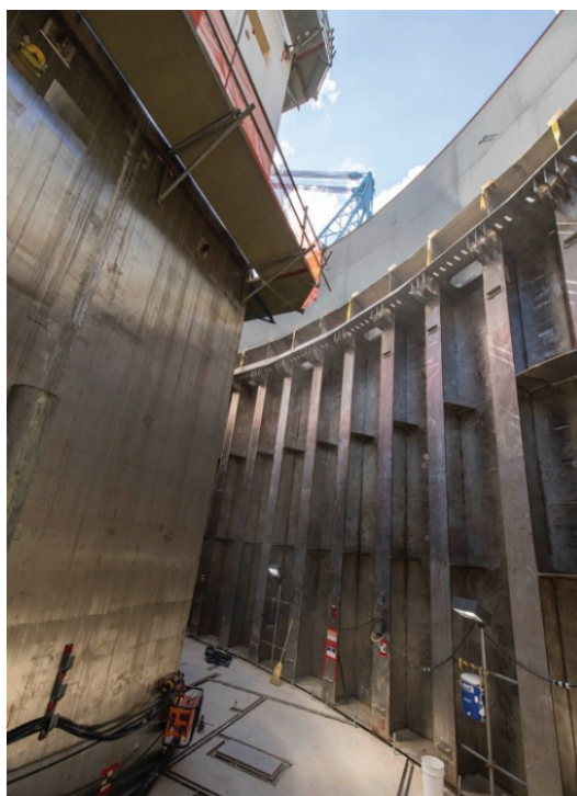
Photo 4. Module CA03, interior of the IRWST tank Fot. 4. Moduł CA03, wnętrze zbiornika IRWST
