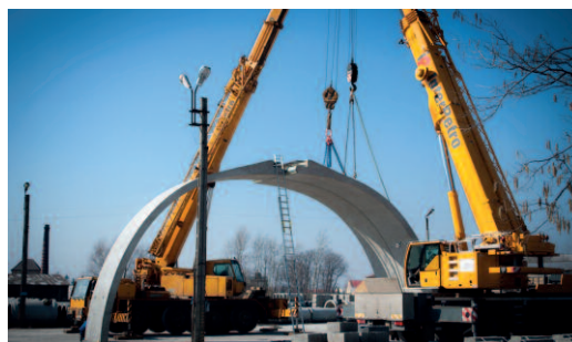
Wyroby Zakładu Betonów w Kolbuszowej - montaż elementów łukowych
