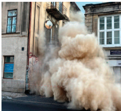
Przebieg katastrofy kamienicy [7, 8]
